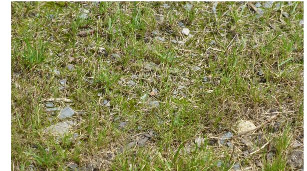
Hierbei handelt es sich um einen speziellen Aufbau mit einer Vegetationstragschicht. Werden die Regelbauweisen eingehalten ist der Flächenbelag dauerhaft wasser-durchlässig und der kontinuierliche Oberflächenbewuchs ist sichergestellt.
