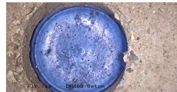
Ungenutzte Grundstücksanschlüsse sind mit formstabilen Füllmaterial zu verschließen oder zurückzubauen!
