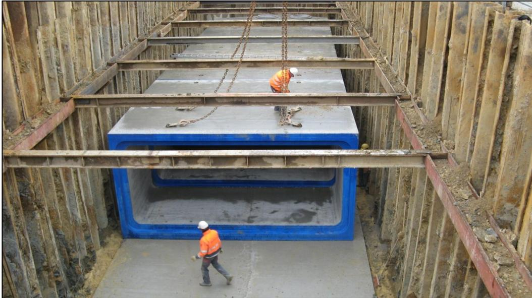
Abbildung 3: Stauraumkanal Gysenberg im Bau 2009
