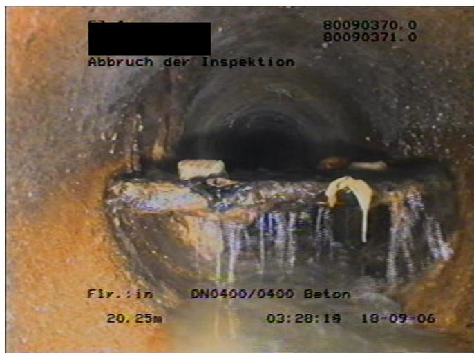
Abbildung 7: Kreuzende Versorgungsleitung im Abwasserkanal
