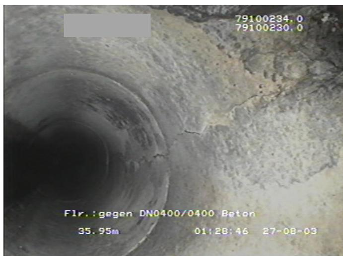
Abbildung 8: Rissbildung in einem Betonkanal
