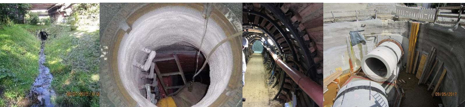
Schäden können auch direkt vor Ort punktuell repariert werden ohne aufwendigen Neubau und Straßenaufbrüche. Die Reparatur erfolgt z. B. durch Kurzliner, Robotertechniken oder Innenmanschetten.
