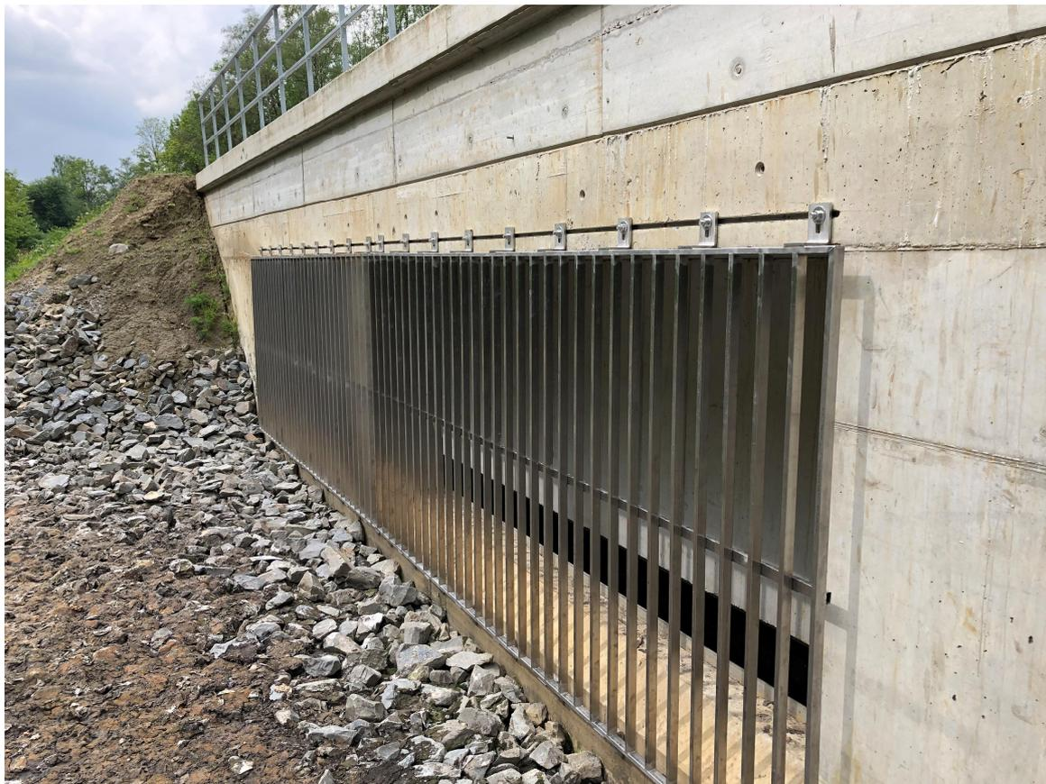
Abbildung 21: Regenüberlauf Fischergraben im Bau
