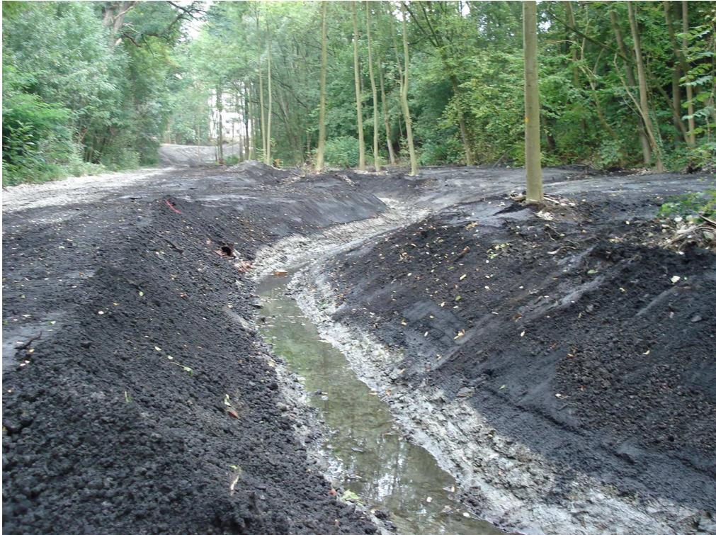
**Abbildung 11: Reinwasserlauf mit integrierter Bestandsbegrünung (38. KW)**
