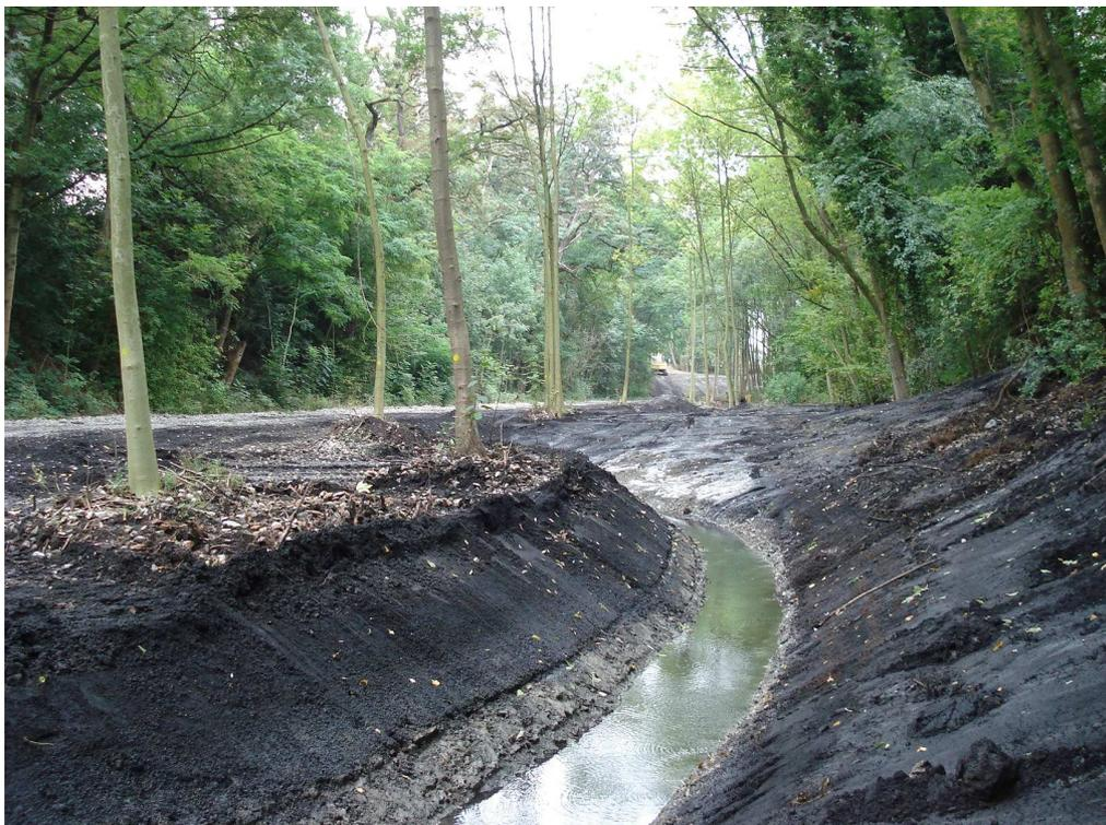
**Abbildung 10: profilierter Reinwasserlauf (38. KW)**
