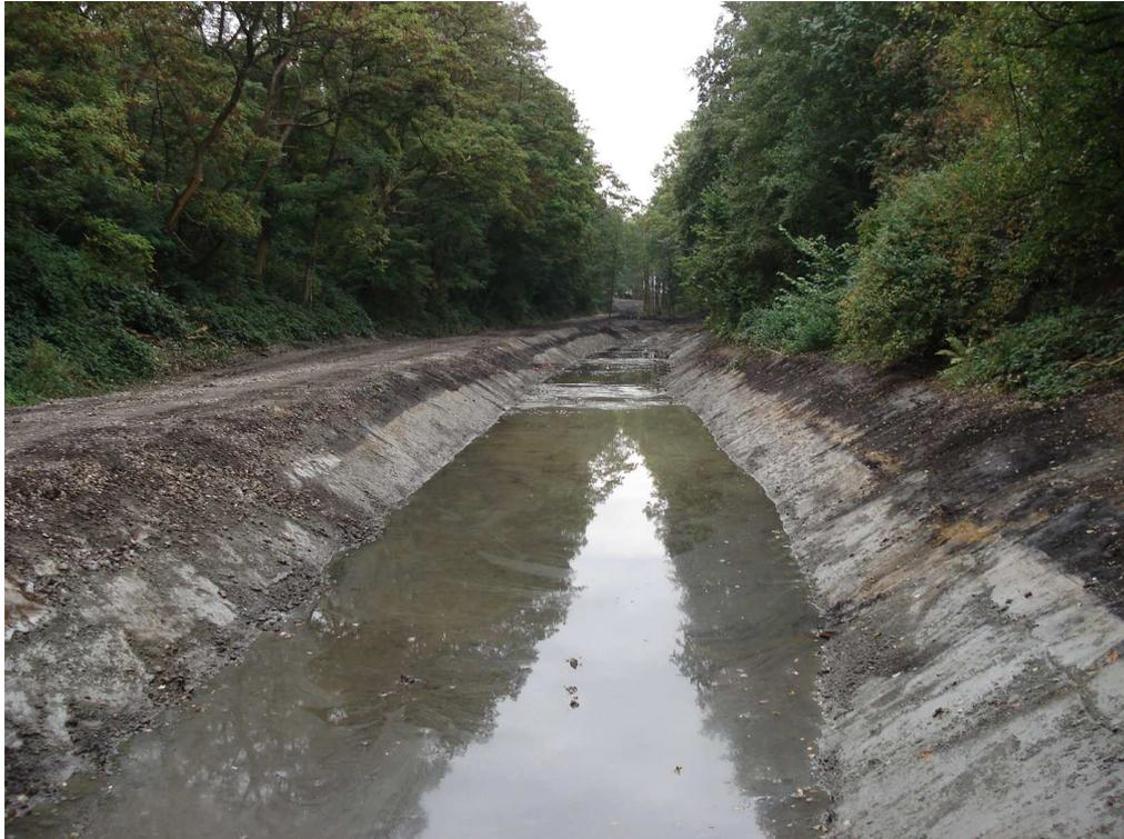
**Abbildung 9: fertig profiliertes RRB**
