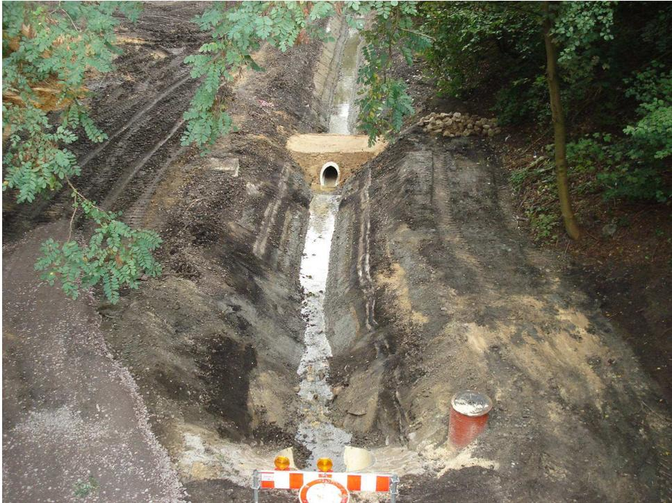
**Abbildung 5: Drosseleinrichtung im Bauzustand, Befestigung mit Wasserbausteinen noch nicht erfolgt; Standort Brücke Riemker Straße gegen die Fließrichtung**
