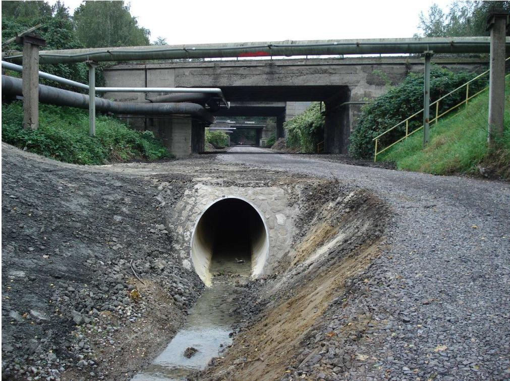
Abbildung 3: GFK-Rohre DN 1600 Blickrichtung Brücke A43; vor der Bepflanzung
