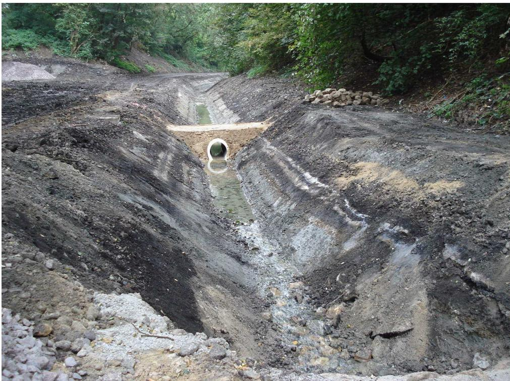
**Abbildung 6: Drosseleinrichtung im Bauzustand**
