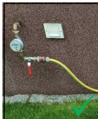
Abb. 2: Beispiele von Zwischenzählern im ungeschützten Außenbereich
