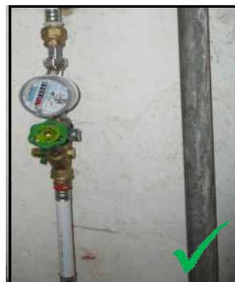
Abb. 3: Beispiele von Zwischenzählern im frostfreien Keller
