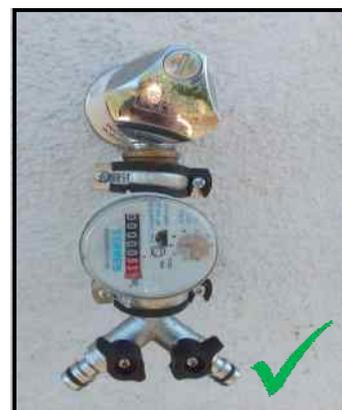
Abb. 4: Beispiele von Zwischenzählern an frostfreien Armaturen
